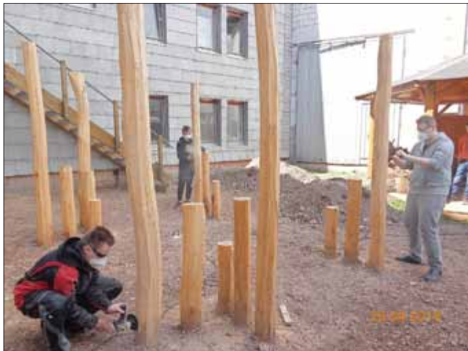
Das Abschleifen der Eichenholzpfiler bereitete viel Mühe
