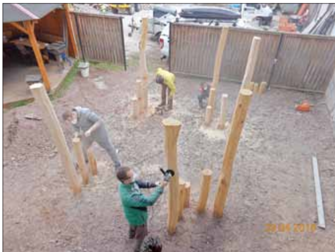
Das Grundgerüst steht, es geht voran
