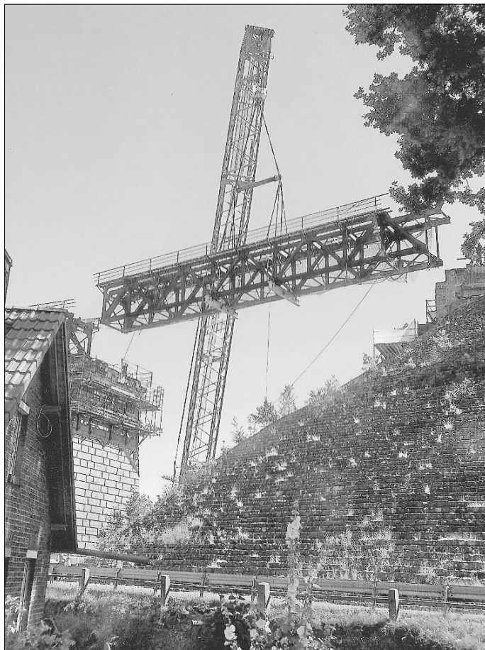
Gesichert durch Netze schwebt das erste, abgetrennte Brückensegment auf den Tieflader.
