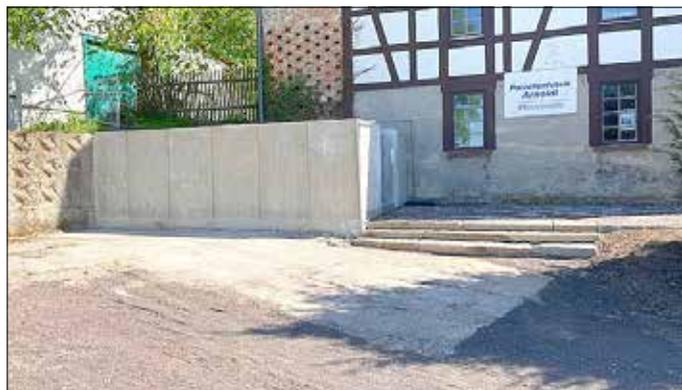
In einem weiteren Arbeitsschritt werden ein Geländer als Absturzsicherung installiert und Pflanzkübel vor der Mauer aufgestellt und bepflanzt.
