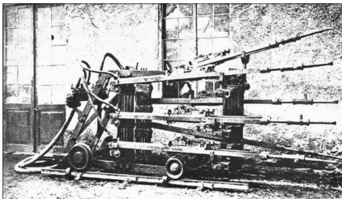
Modernste Technik 1883. Mit diesen Stoßbohrmaschinen konnten maximal 4m Vortrieb am Tag geschafft werden.
