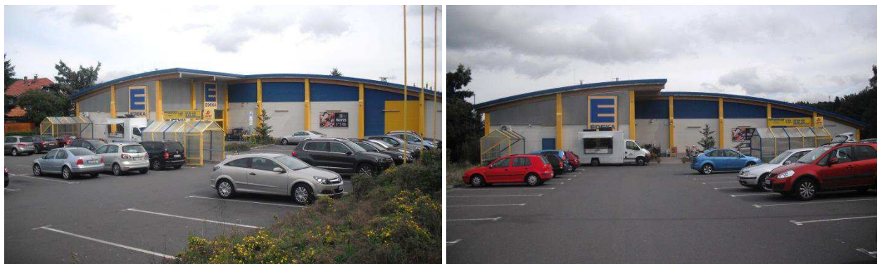
Abbildung 1: Objektsituation auf dem Vorhabengrundstück Gewerbepark 5 in Geraberg
