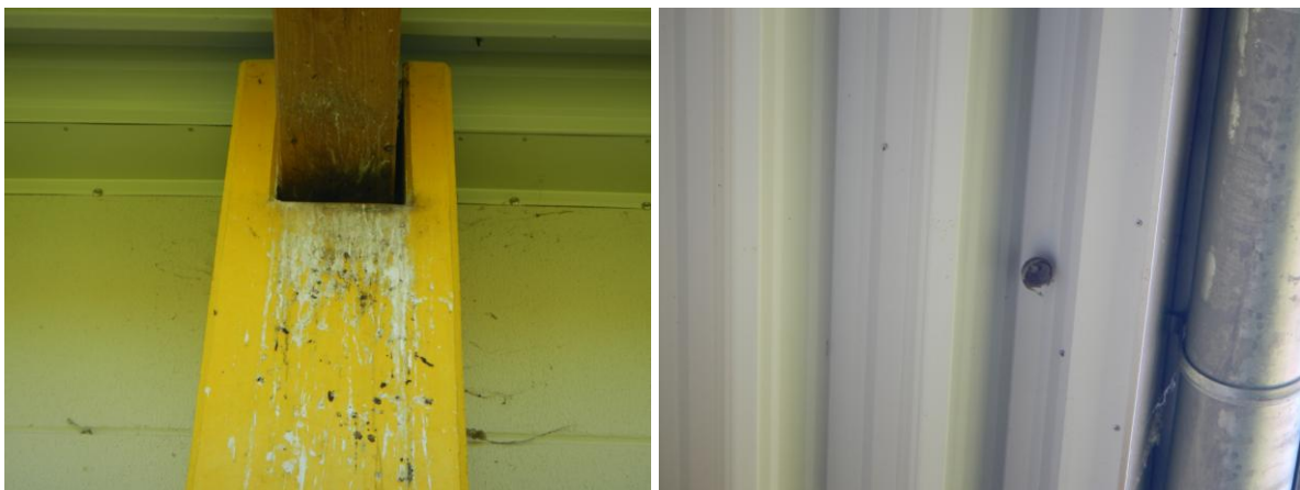
Abb. 5: Nordfassade mit Starennestern und einem Wespennest
